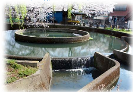
久地円筒分水
